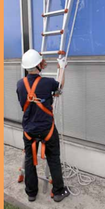
2_Avvicinare la scala a pioli alla corda e collegare l'imbracatura alla corda tramite il dissipatore.
